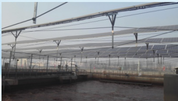
鱼腹式悬索支架安装完成（常规边框组件）
