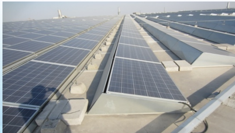
混凝土配重形式一 （配重模块）
