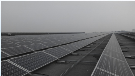
混凝土配重形式一 （配重模块）
